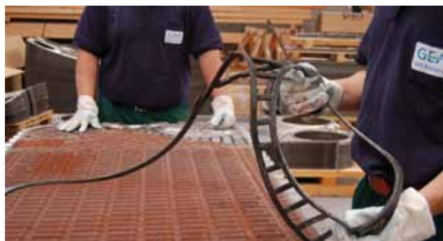
Remoção de gaxetas
